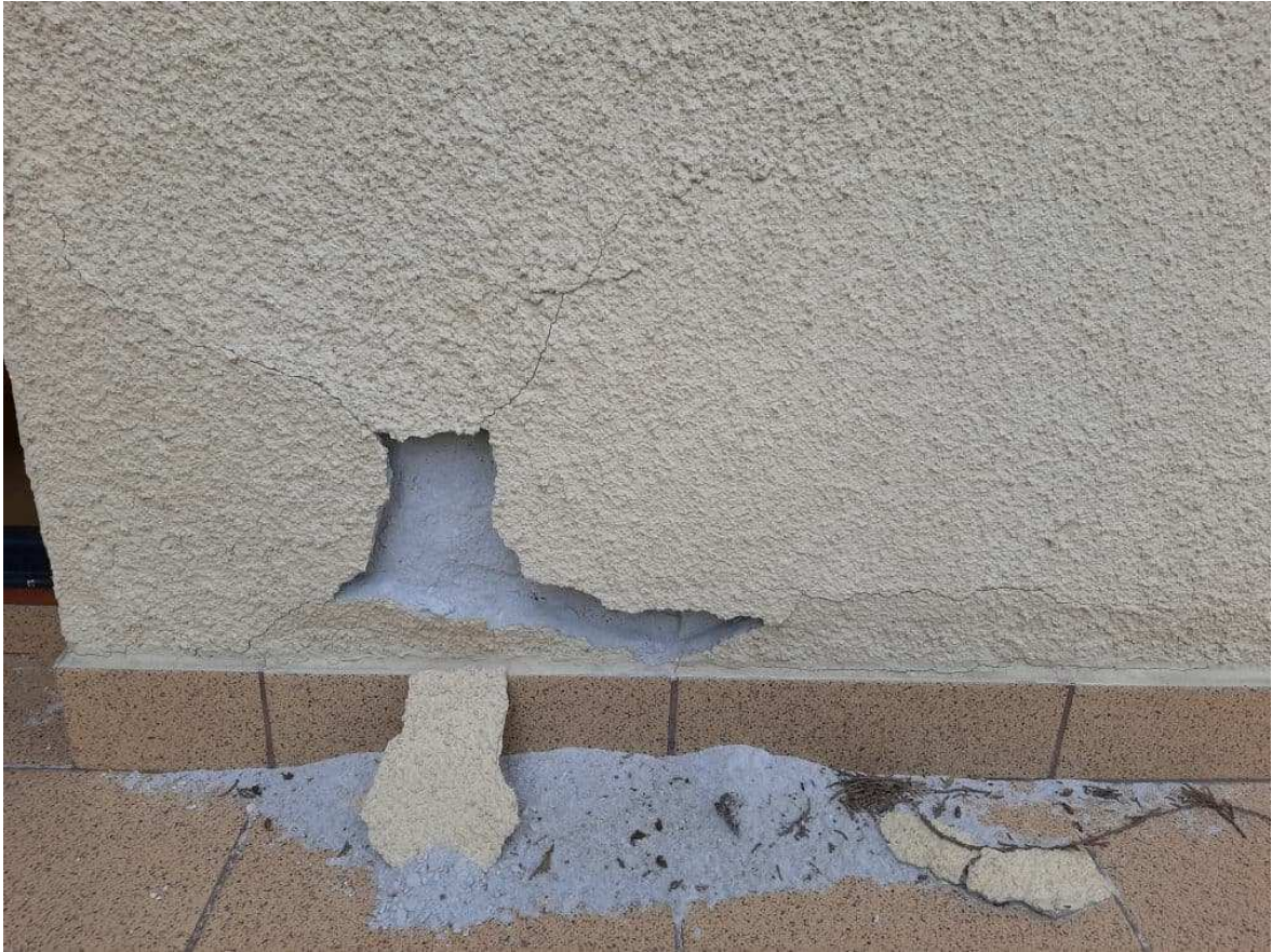
Odpadający tynk nad balkonem
